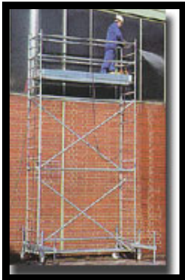
Aufbau von Rollgerüsten:
